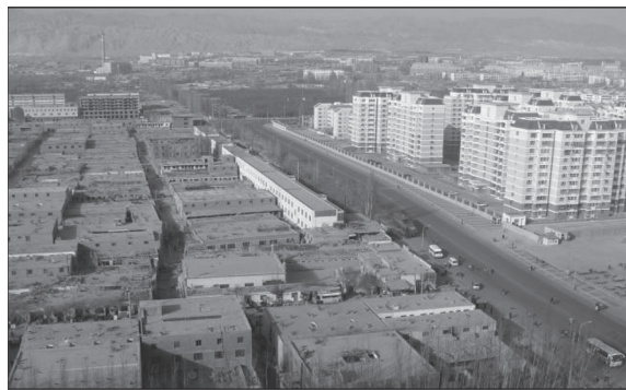
图 4 库尔勒市城中村建设现状
