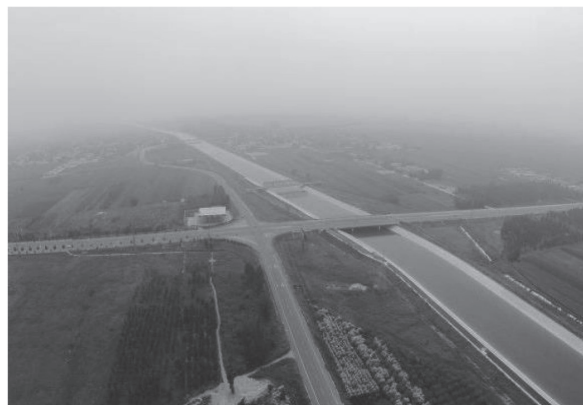
图4 内丘县南水北调河道
