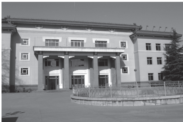
石家庄棉二主楼
