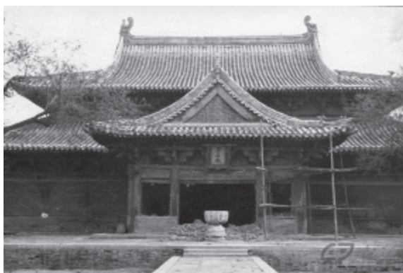
隆兴寺摩尼殿。梁思成 摄于 1933 年
