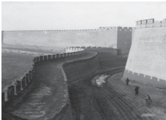
正定古城墙东城门里城、瓮城、月城墙。 梁思成 摄于1933年
