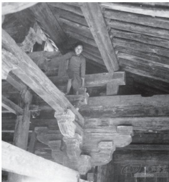
林徽因在开元寺钟楼梁架上测绘。
