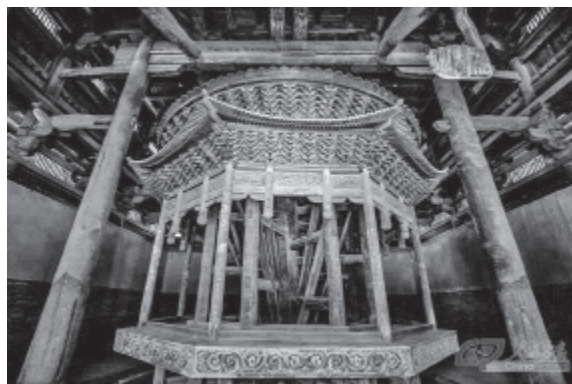
建造于北宋的木制转轮藏，是一个能够转动的大书架，直径7米，整体分为藏座、藏身、藏顶三部分，中间设一根10.8米的木轴上下贯穿。摄影 郭莎莎
